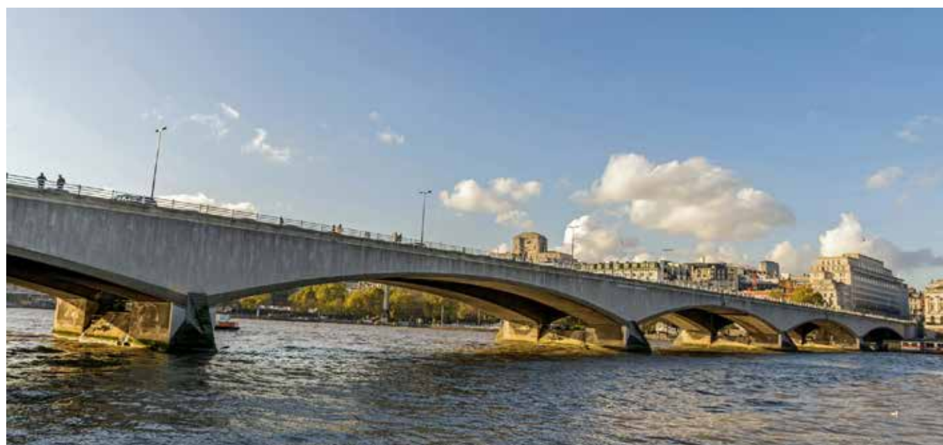
"Dankzij geavanceerde monitoringtechnieken kunnen we het gedrag van Waterloo Bridge, de oude verkeersbrug over de Thames, beter begrijpen."
