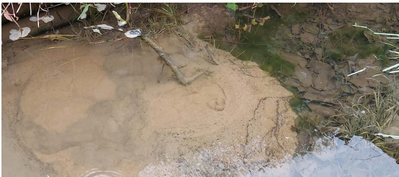
Drie zandmeevoerende wellen die zijn geobserveerd tijdens het hoogwater van afgelopen winter (februari 2021) langs de rechter oever van de Waal bij Ochten. (Foto: André Broere, WSP)
