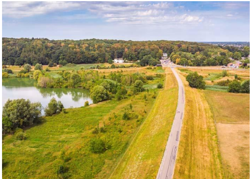
De Roadmap Duurzame Dijkversterking biedt handvatten om tot een goed eindresultaat te komen. (Foto: Koen Mol)
