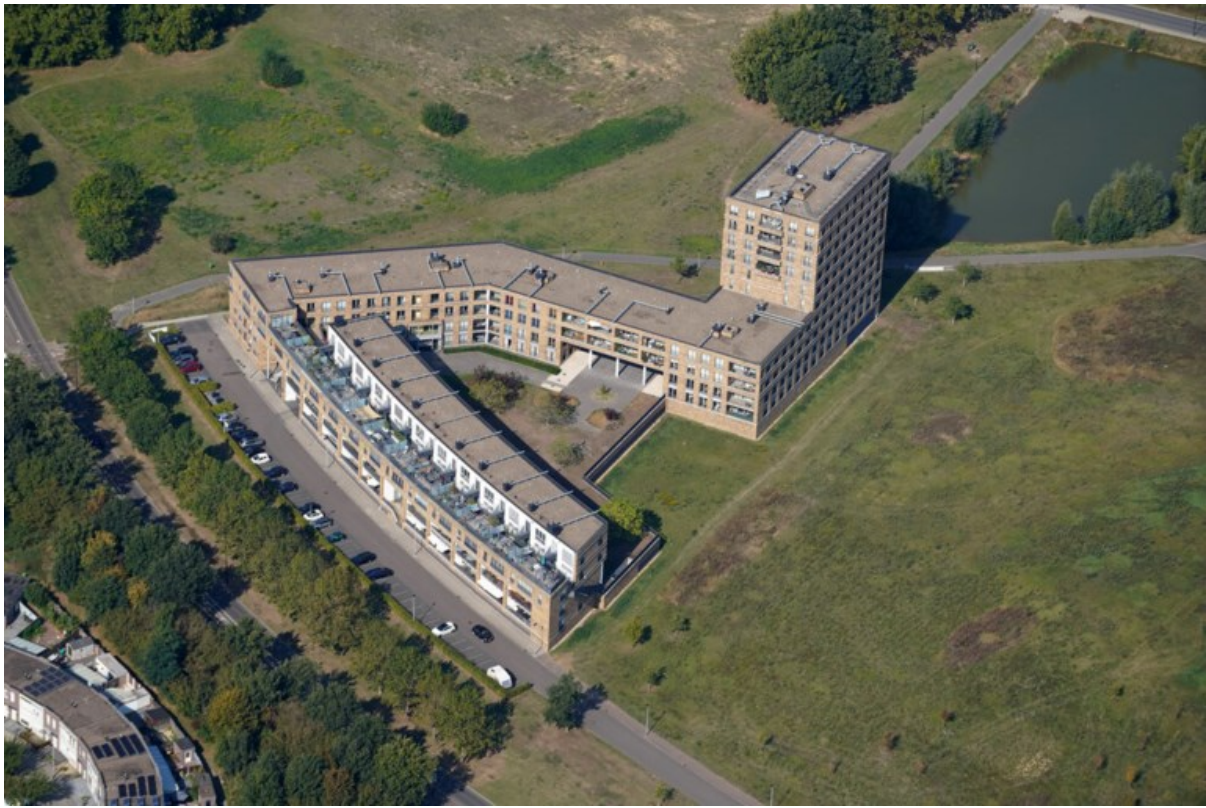
Het nu geïsoleerde Cour Renoir 1. Foto: Aerovista
