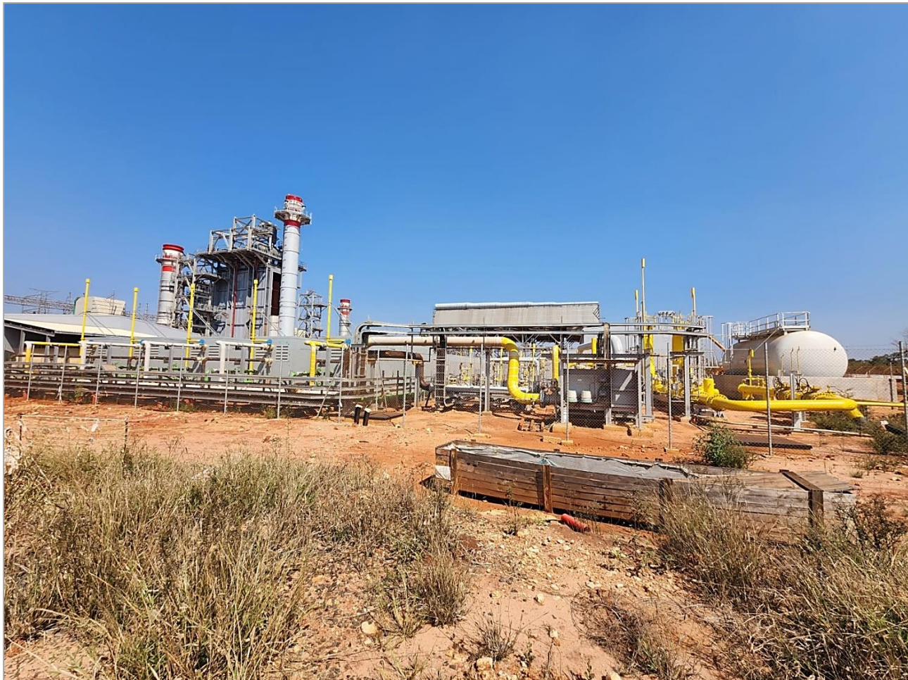
Figura 2-3 - Perspectiva do local da central térmica de Temane a mostrar o progresso da construção
