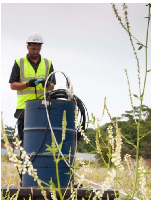
In-situ sanering av förorenat grundvatten.
